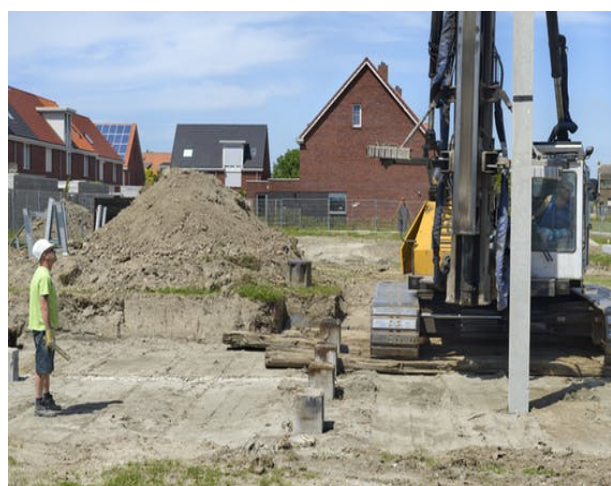
Heipalen worden geslagen in een Nederlandse nieuwbouwwijk. Bij verantwoordingsorganen ontbreekt geregeld de onderbouwing van een oordeel. Foto David Rozing / HH
